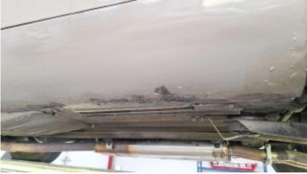
Corrosion bas de caisse
