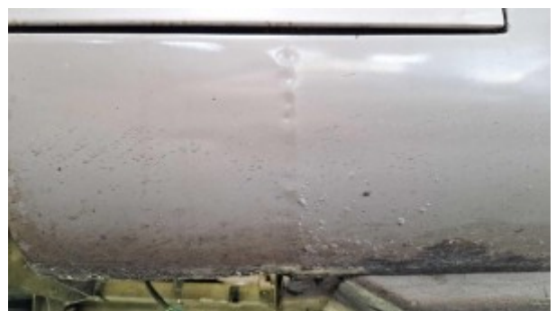
Cloques de corrosion bas de caisse
